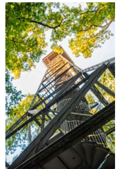
Meisterturm, Hofheim a. Ts.
