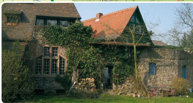
8 Altstadt Dreieichenhain: Gebäuderückseite südlich des Untertores
