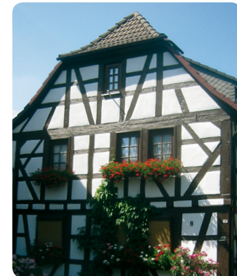
8 Altstadt Dreieichenhain: Fachwerkhaus Fahrgasse
